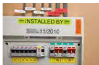
Panneaux, armoires, données, communications
