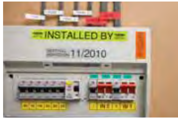
Panneaux, armoires, données, communications
